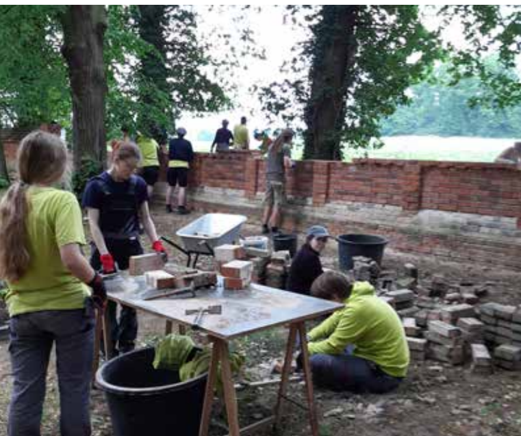
Ergänzungsarbeiten an der Friedhofsmauer in Vollenschier
